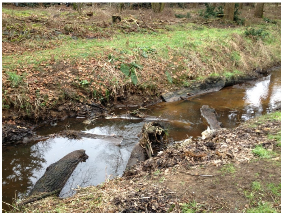
Afbeelding 3.1 Stammen in visgraatmotief in de Snelle Loop in februari 2013.
