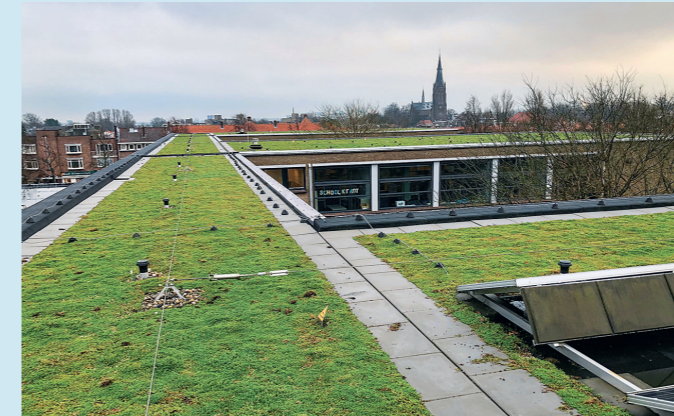
Sedumdaken na aanleg. (Foto: Universal Greenfields)
