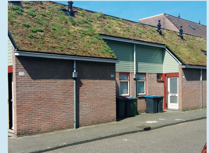
De korte en lange schuine daken met Ecopannen. (Foto: H. Teekens)
