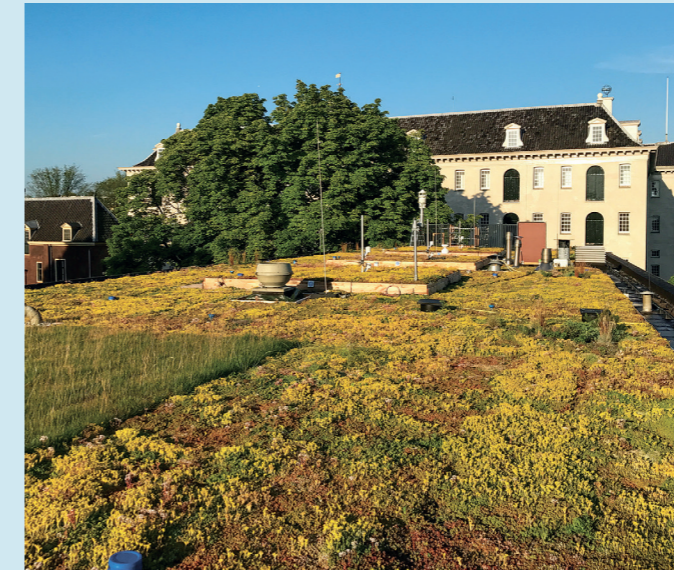
Overzicht van het meetak met zichtbaar verschil tussen de sedummixmatten en een vegetatietest met grasmatten. (Foto: Joris Voeten, Urban Roofscapes)
