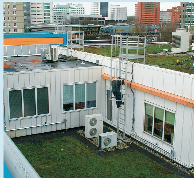
Dak 17, het groene dak met ervoor het zwarte dak tijdens het aanbrengen van de meetapparatuur. (Bron: Stadsontwikkeling Rotterdam, W. van Bommel)
